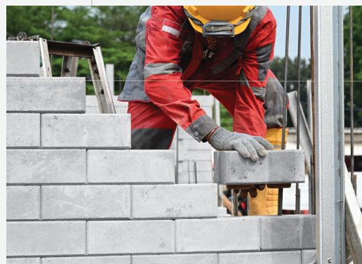
Proses Pemasangan BIP
